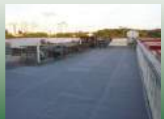
TW-181 PU Hybrid Waterproofing-2 nd Coat
